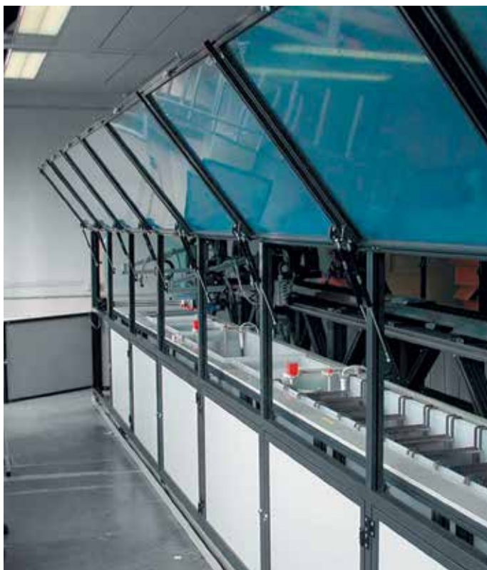
Impianto automatico di doratura
