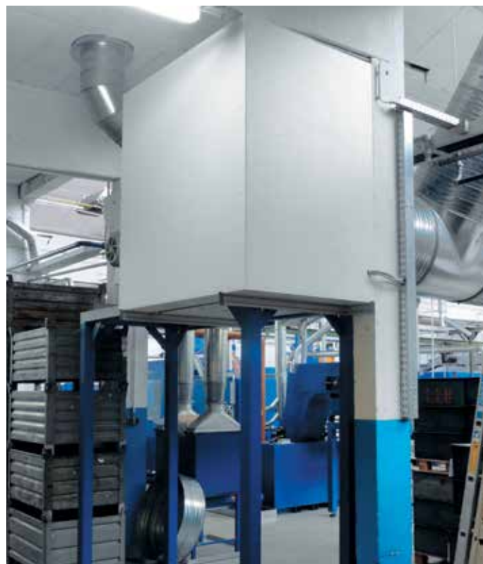
Rivestimento insonorizzante parziale semi-aperto per scambiatore di calore
